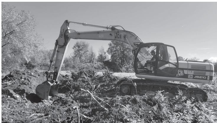
Слика 7-5. Вађење пањева и коријења (фото: Матаруга, 2023)
