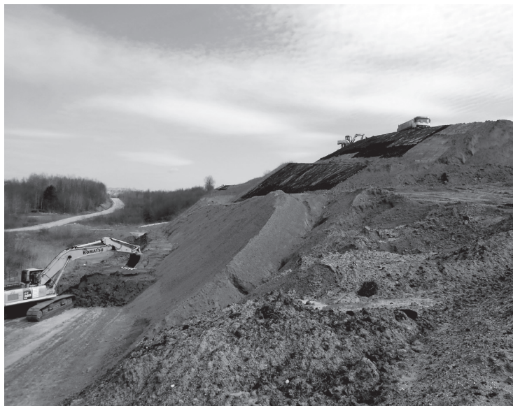
Слика 14-12. Радови на техничкој рекултивацији и стабилизацији завршних косина (фото: Малић, 2021)
