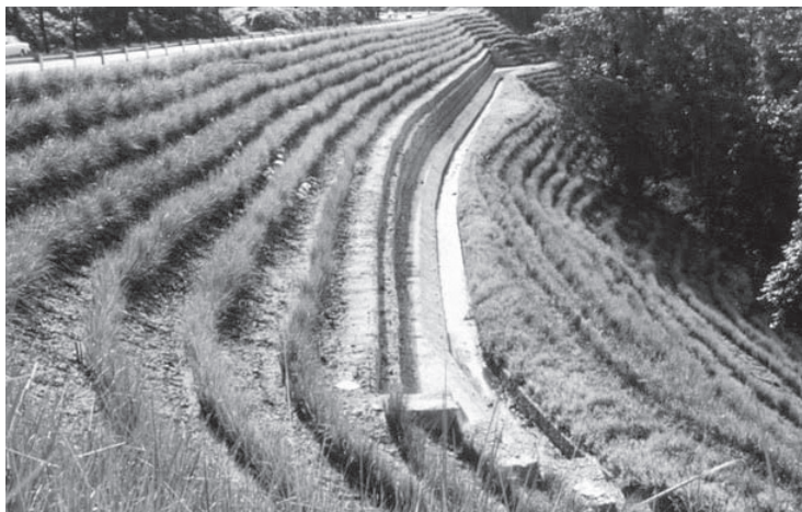
Слика 16-8. Вертивер (Vertiver) технологија у борби против ерозије земљишта (извор: www. appropedia.org/ images )
