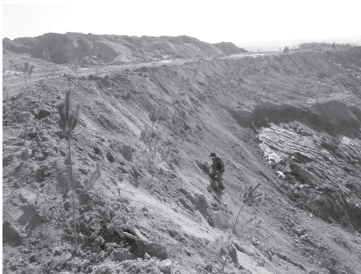
Слика 14-14. Пошумљавање косина (Малић, 2022)
