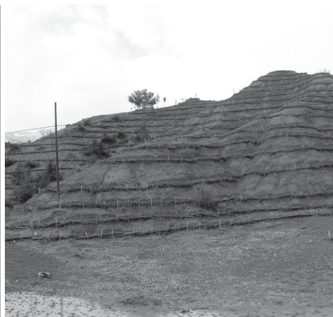
Слика 14-11. Фашине постављене на терену (фото: Sivacioğlu, 2018)
